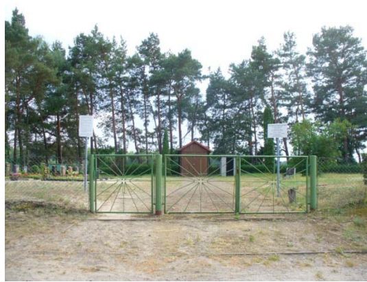
Zufahrtstor zum Friedhof von der Straße
