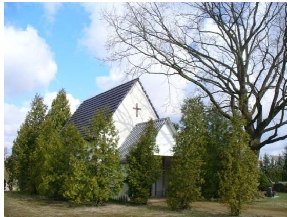
Blick zur Feierhalle
