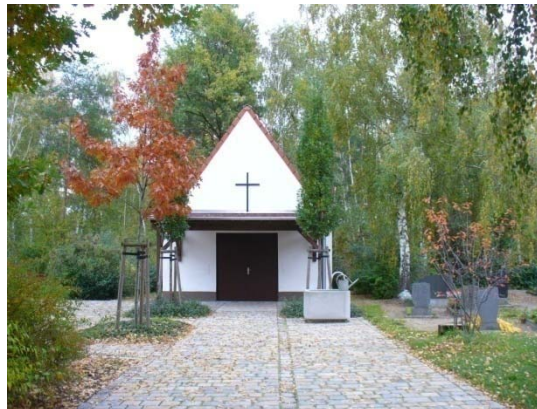
Blick zur Feierhalle
