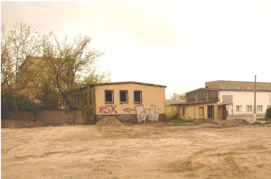
Abbildung 8: Gewerbebrache mit leerstehenden Häusern und Umlagerungsfläche.
