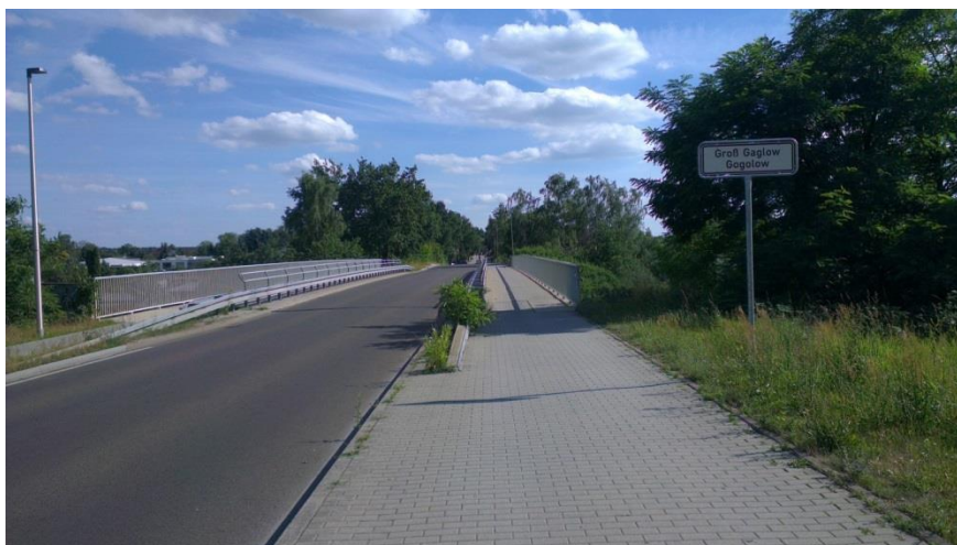
Foto: Brücke Zielona-Gora-Straße über BAB 15, Richtung Süden
