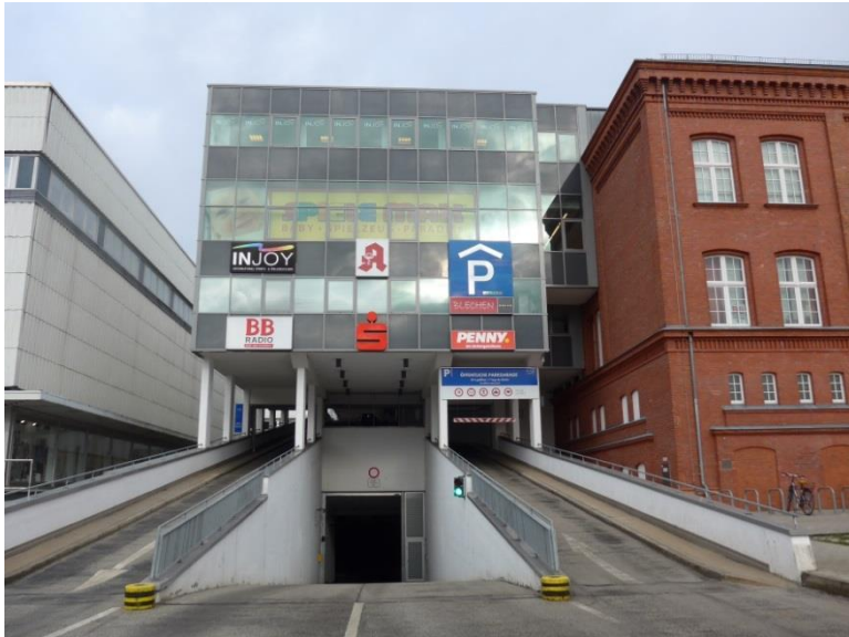
Abbildung 1-6: Einfahrt in das Parkhaus Blechen Carré mit Lieferzufahrt
