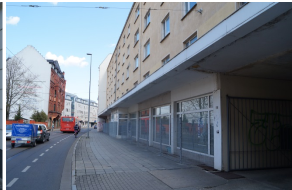
Abbildung 27: Leerstehende Gebäude im Zuge der Straße der Jugend
