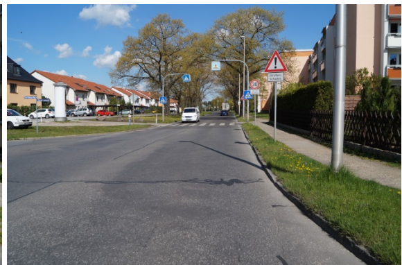
Abbildung 33: Sielower Landstraße zwischen Goyatzer Straße und Am Nordrand
