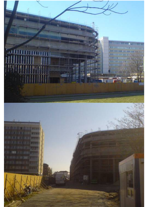
Abb. 14: Einkaufszentrum „Bleichen Carré“ in Bau
