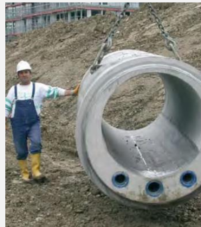
Abb. 72 – Kanalwärmetauscher
