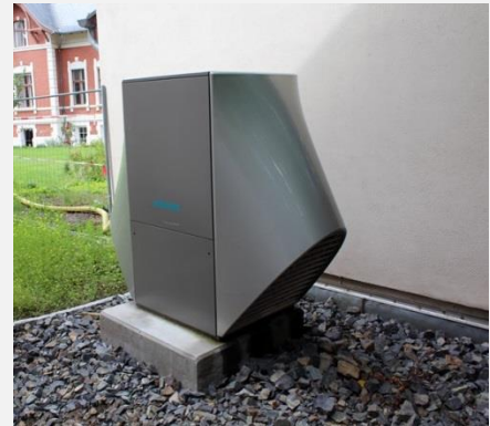
Abb. 48 - Luftwärmepumpe
