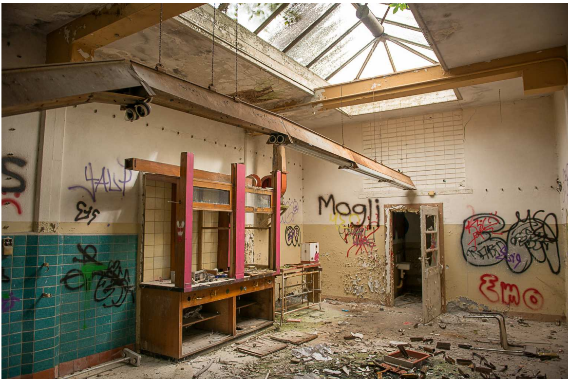
Innenansicht des eingeschossigen Gebäudes am Ostrand des Plangebiets
