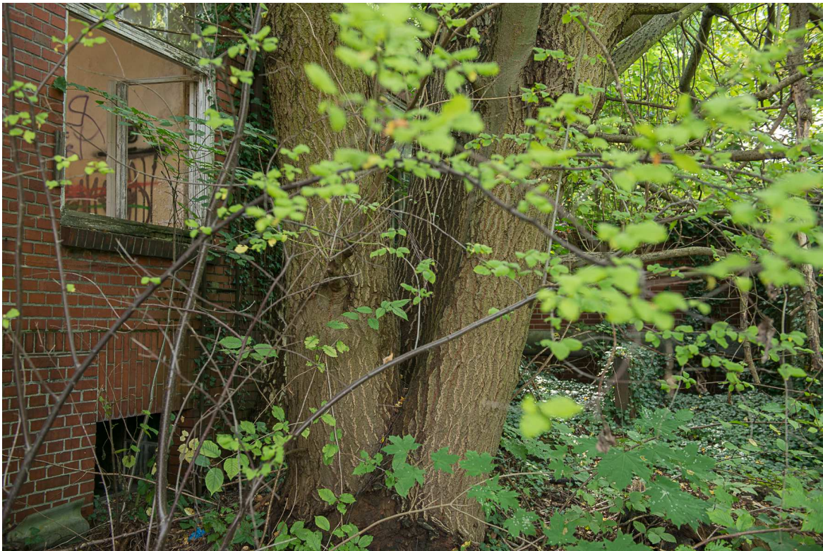
Blick auf die Nordfassade des eingewachsenen, eingeschossigen Gebäudes am Ostrand der Vorhabensfläche. Im Vordergrund 3-stämmige Sal-Weide
