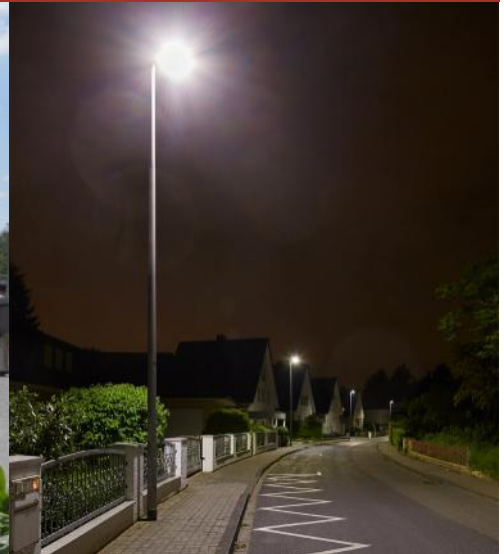
118 Beispielhafte einseitige Straßenbeleuchtung
