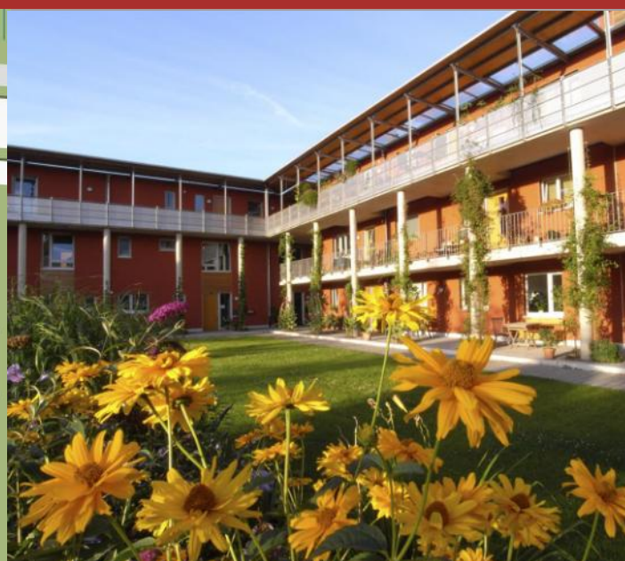
140 Mehrgenerationenwohnen am Tremoniapark in Dortmund
