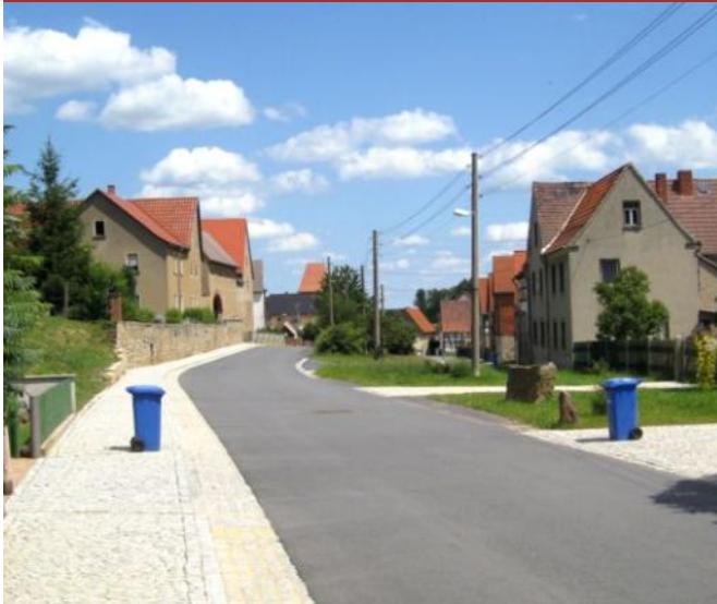
119 Ausbau und Neugestaltung eines Straßenraums (Walperhain)
