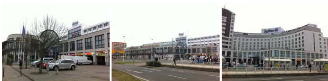
Abbildung 37: Ansichten des integrierten Einkaufszentrums mit Stadtteilbedeutung Fürst-Pückler-Passage (C-Zentrum)
