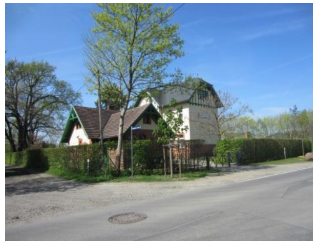
Abb. 37 – ehem. Merzdorfer Bahnhof (Foto: DSK)
