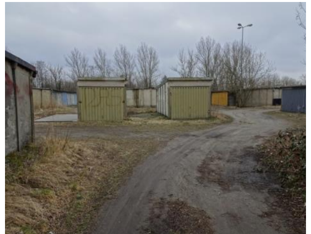
Abb. 31 – Garagenkomplex (Foto: DSK)
