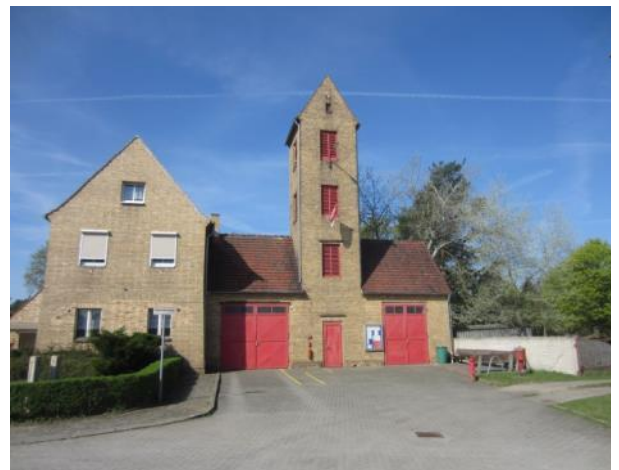
Abb. 39 - Feuerwehrhaus in Dissenchen (Foto: DSK)
