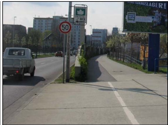
Abb. 33 Vorhandene Schallschutzwand Stadtring
