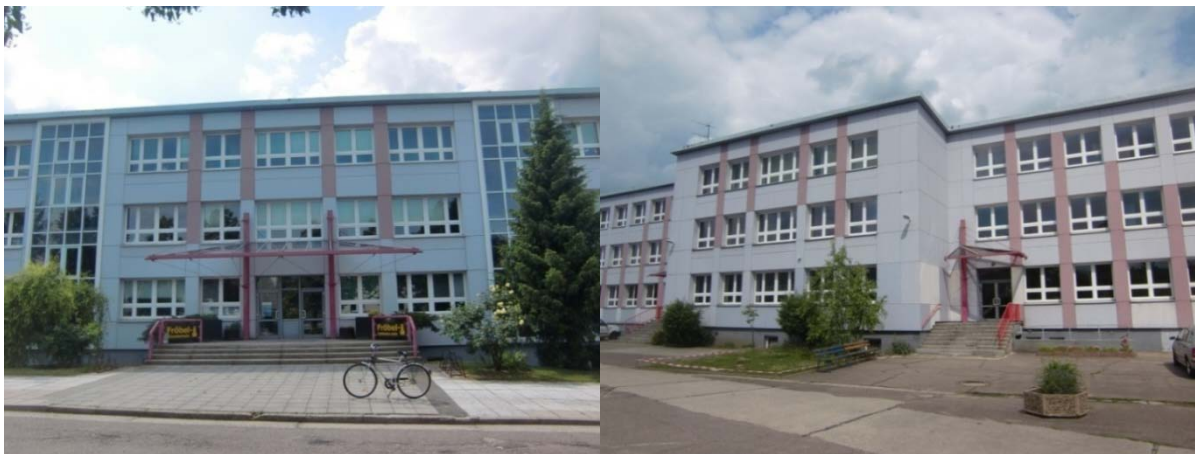
Abbildung 59: Straßen- und Hofansicht der Fröbelgrundschule, eigene Fotos
