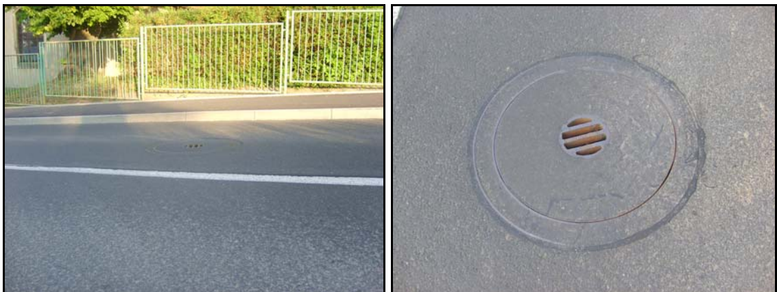
Abb. 38 Lärmarme Schachteindeckung (Beispiel Dresden)
