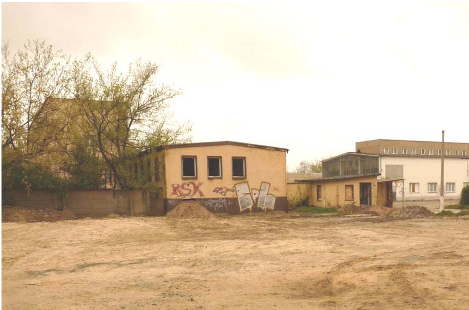
Abbildung 8: Gewerbebrache mit leerstehenden Häusern und Umlagerungsfläche.
