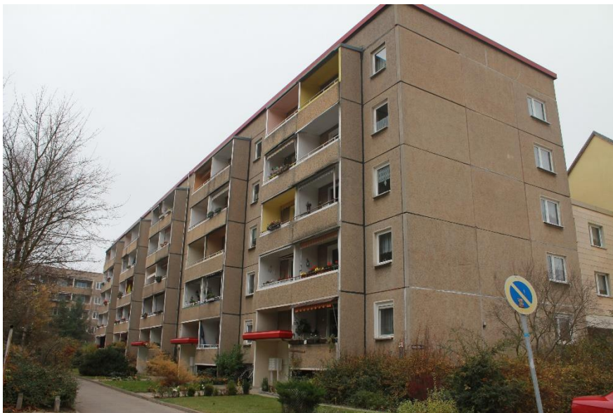
Abbildung 62: Beispiel für ein Wohngebäude vom Typ IWB-P2 in der Hühnerstraße, eigenes Foto
