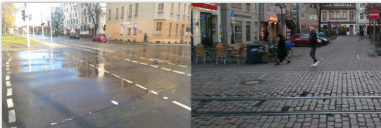
Abbildung 4-31 Fahrbahndefizite: Spurrillen (Karl-Marx-Straße) und mangelhafter Pflasterbelag (Berliner Straße)
