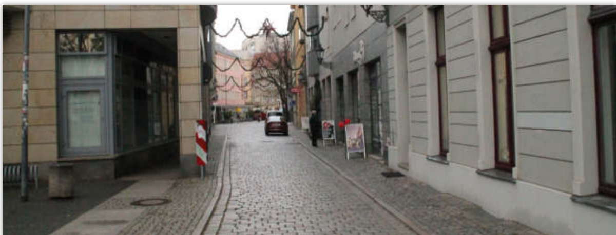
Abbildung 4-5 Defizite bei der Gehwegbemessung: Beispiel Schlosskirchstraße
