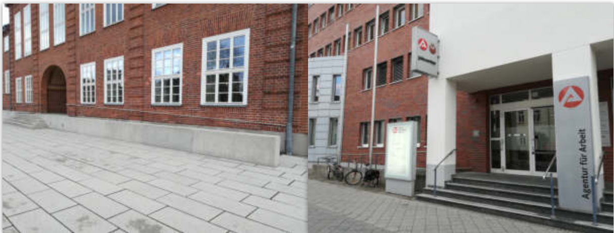
Abbildung 4-8 Barrierefreier Zugänge: Stadthaus und Jobcenter
