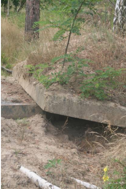
Abdeckungen auf dem Bunker mit Zuflugsmöglichkeiten
