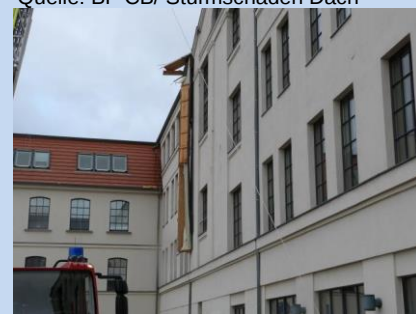
Quelle: BF CB/ Sturmschaden Dach
