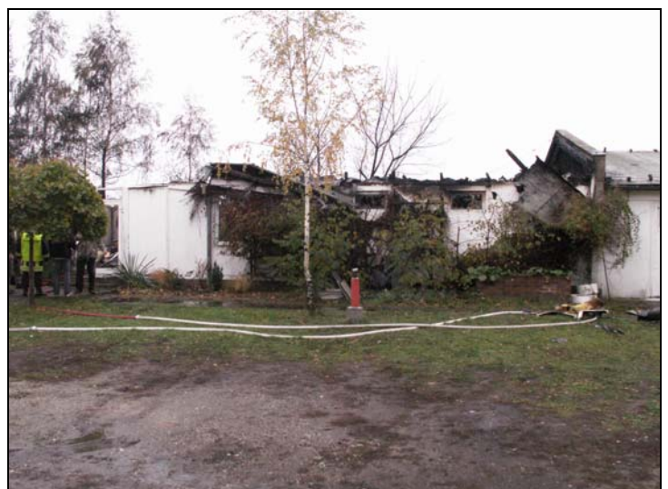
Gehaltene Gebäude zu beiden Seiten des Brandobjektes
