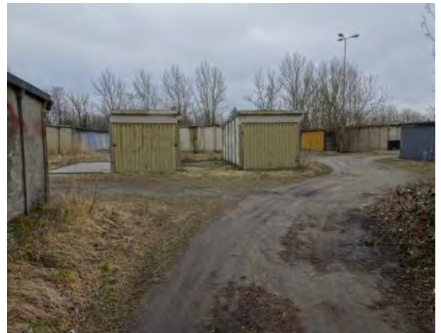
Abb. 31 – Garagenkomplex (Foto: DSK)
