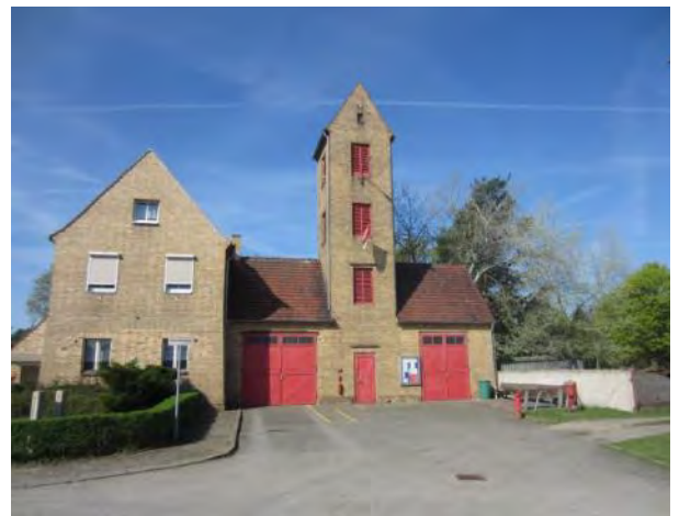
Abb. 39 - Feuerwehrhaus in Dissenchen (Foto: DSK)
