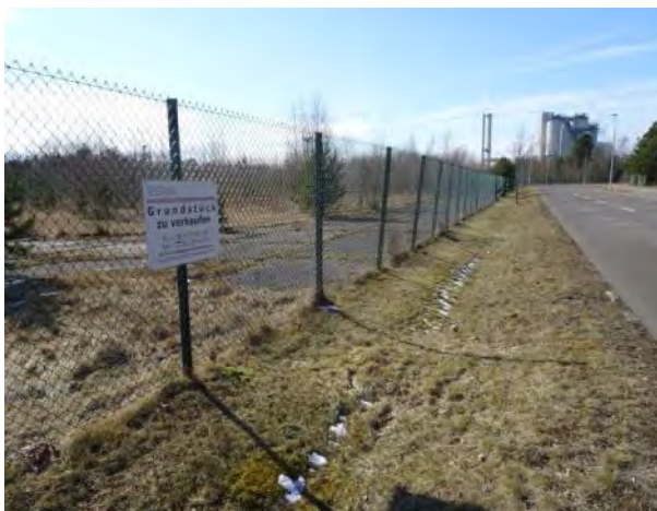
Abb. 54 - Gewerbe am Heizkraftwerk (Foto: DSK)
