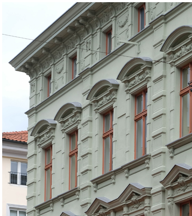
SCHLOSSKIRCHPLATZ | Schmuckelemente schließen den Einsatz von außenliegender Wärmedämmung aus
