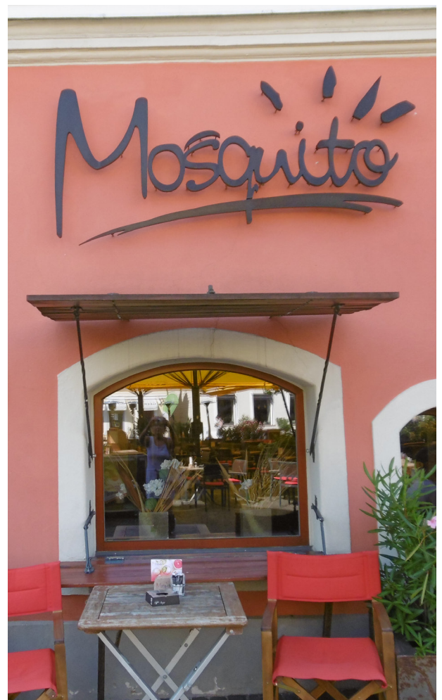
ALTMARKT 22 | Mittelalterliche Fensteröffnungen, sogenannte „Scharren“, zum Warenverkauf
