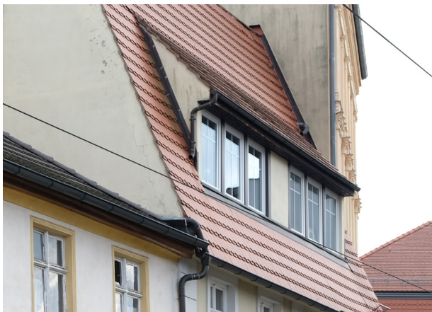
SANDOWER STRASSE Schleppdachgaube
