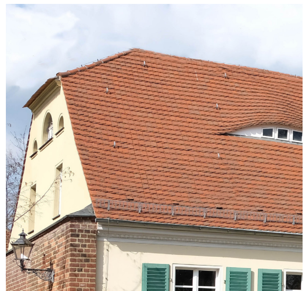
SANDOWER STRASSE Küppelwalmdach
