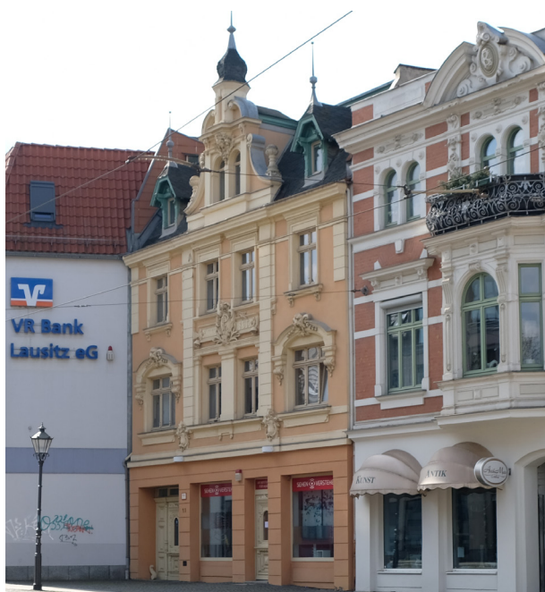
SANDOWER STRASSE Zwerchhaus mit durchgehender Traufe
