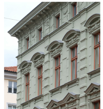
SCHLOSSKIRCHPLATZ | Schmuckelemente schließen den Einsatz von außenliegender Wärmedämmung aus
