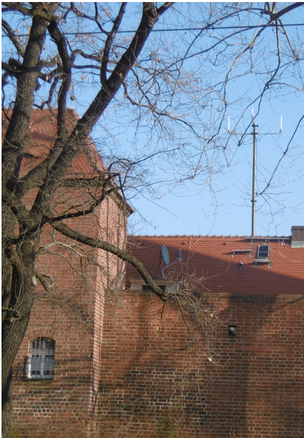
STADTMAUER | Blick auf Dach Mauerstraße 5 mit Antenne
