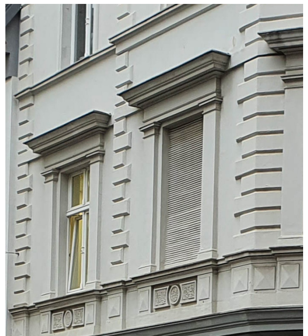
BURGSTRASSE Rollläden ohne sichtbare Rollladenkästen
