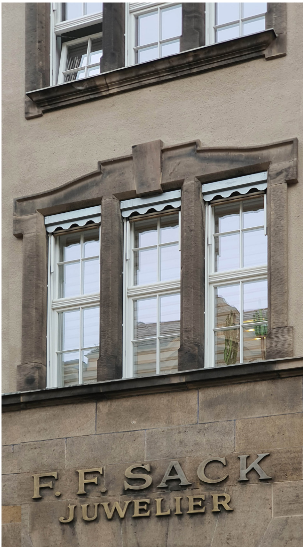
SPREMBERGER STRASSE Sonnenschutzelemente innerhalb der Gewände
