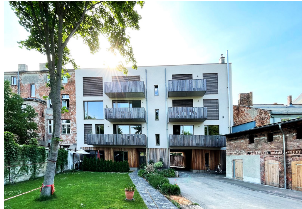
Fotos Baugruppe Hoch 5 – Innenhof und Freianlagen
