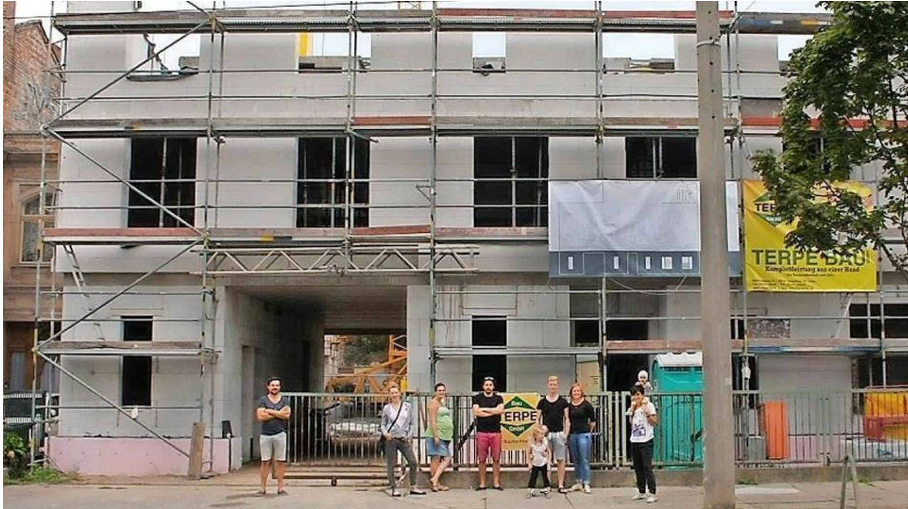
Foto Baugruppe Hoch 5 – Haus im Rohbau
