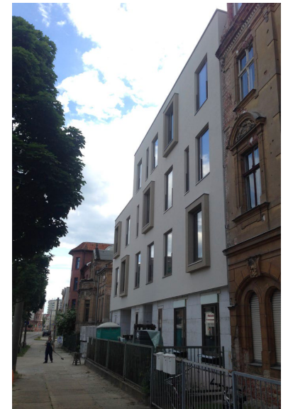
Fotos Baugruppe Hoch 5 – Hausbau
