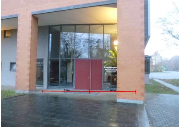
Abbildung 1: Ansicht Hauptzugang zur Erstinformationsstelle Feuerwehr (BMZ)
