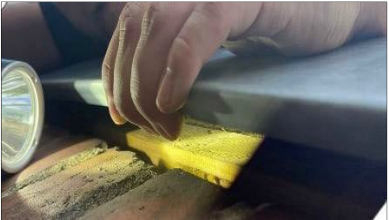
Abb. 25: Untersuchung des Dachrands vom Hauptgebäude (Abb. 2 Nr.1)
