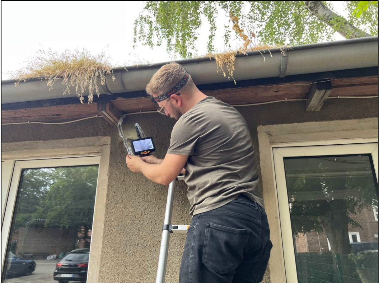
Abb. 9: Kontrolle potenzieller Quartierstrukturen mittels Endoskop am Lagerschuppen (Abb. 2 Nr. 2)
