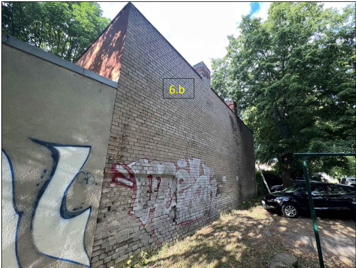
Abb. 8: 6b = Erweiterungsgrundstück mit Rückwand eines Objektes mit Spaltenpotenzial
