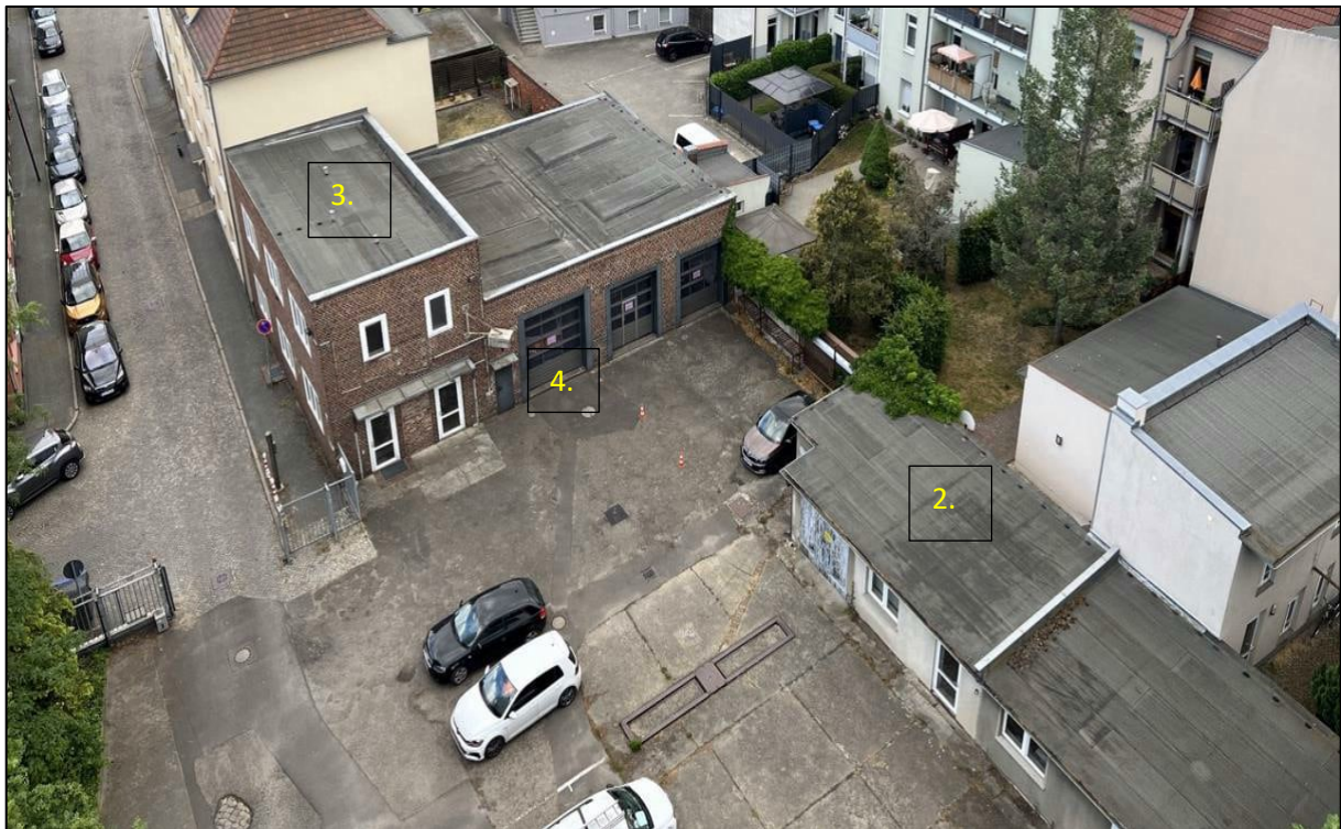
Abb. 4: 3 = Mehrnutzungsgebäude Feuerwache 2, Nr. 2 = massiver Lagerschuppen auf dem Gelände der Feuerwache 2
