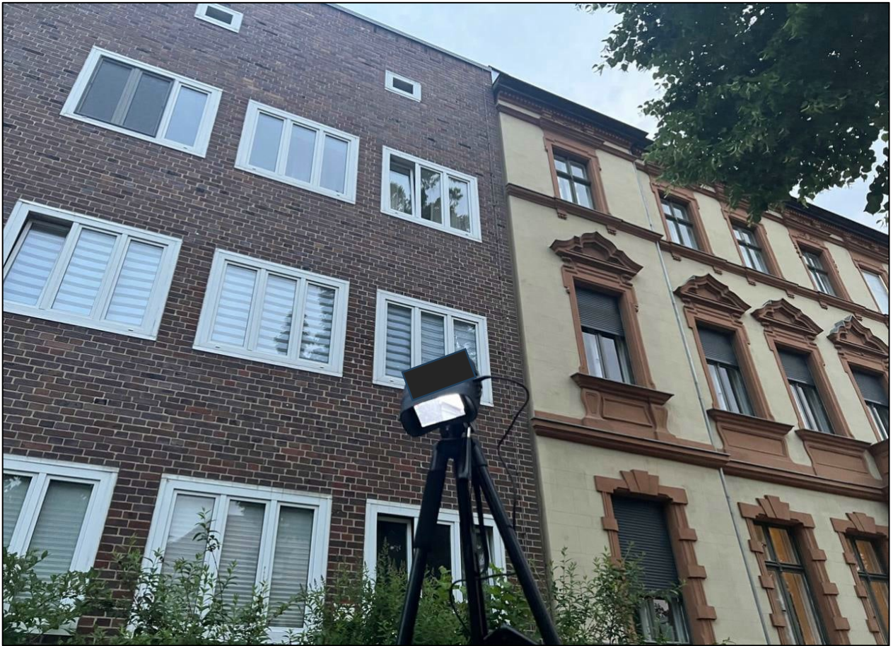
Abb. 26: Untersuchung einer Struktur am Dachrand mittels Nachtsichtkamera.
