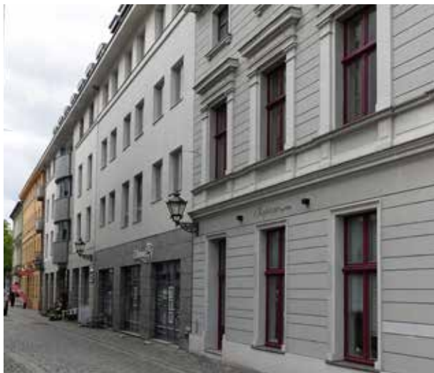
SCHLOSSKIRCHSTRASSE Fassadenanschluss ohne Versatz
