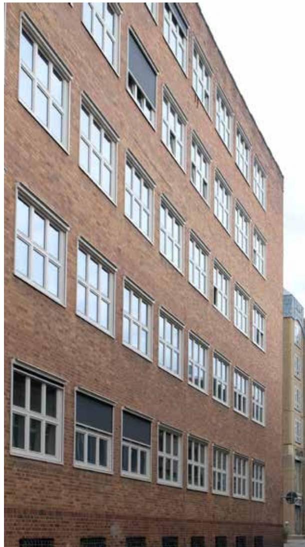
MARKTSTRASSE Einheitliche Sonnenschutzelemente
