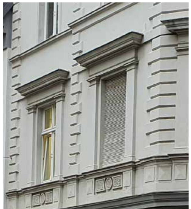
BURGSTRASSE Rollläden ohne sichtbare Rollladenkästen
