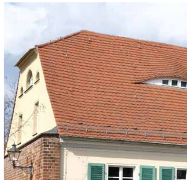
SANDOWER STRASSE Krüppelwalmdach
