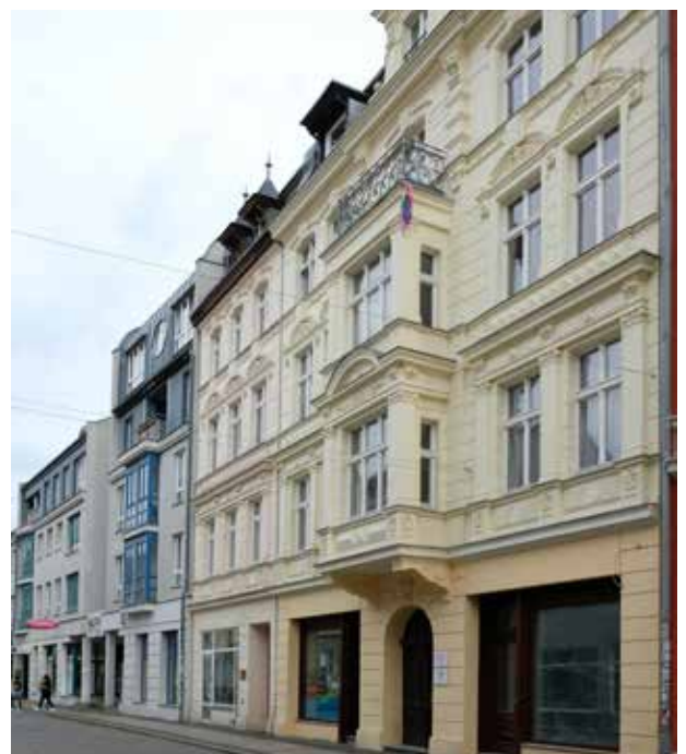
MÜHLENTRASSE Vorspringender Erker und Balkon
