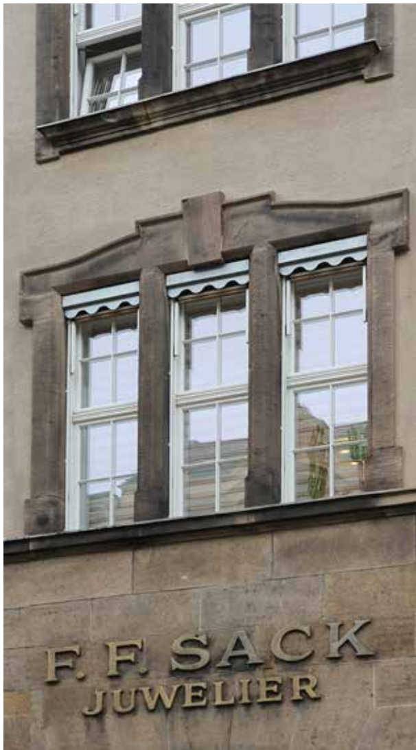
SPREMBERGER STRASSE Sonnenschutzelemente innerhalb der Gewände
