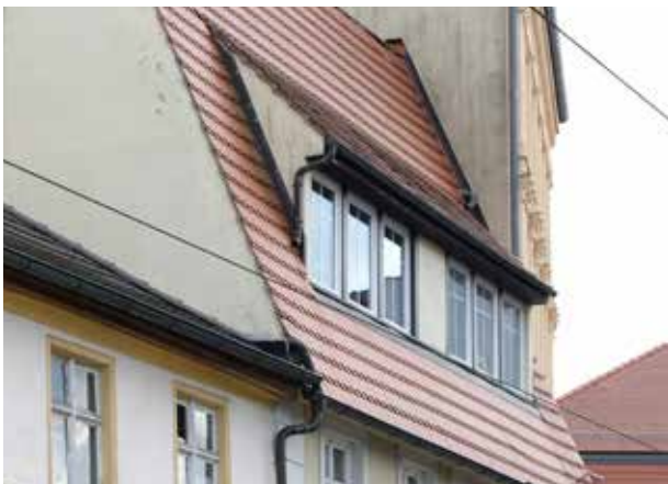
SANDOWER STRASSE Schleppdachgaube
