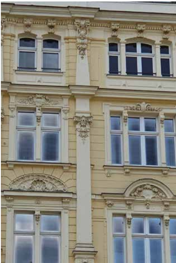
ALTMARKT | Monochrome geringfügig abgesetzte Gestaltung der Fassadenschmuckelemente
