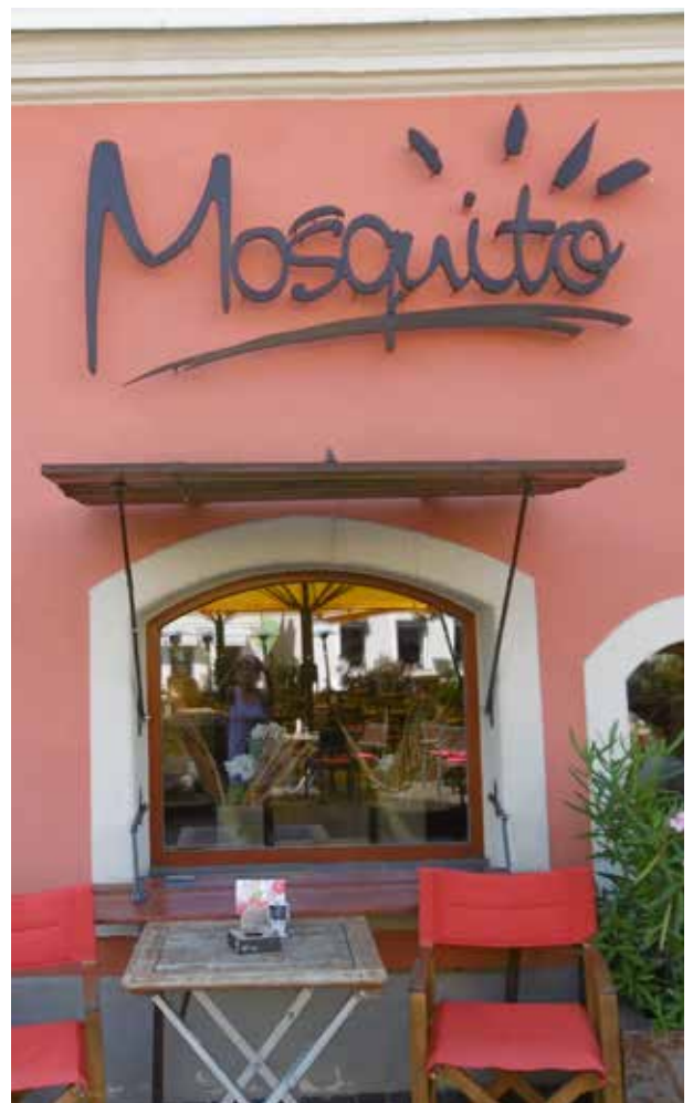
ALTMARKT 22 | Mittelalterliche Fensteröffnungen, sogenannte „Scharren“, zum Warenverkauf
