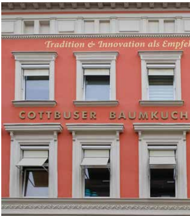
MÜHLENSTRASSE Einheitliche Sonnenschutzelemente
