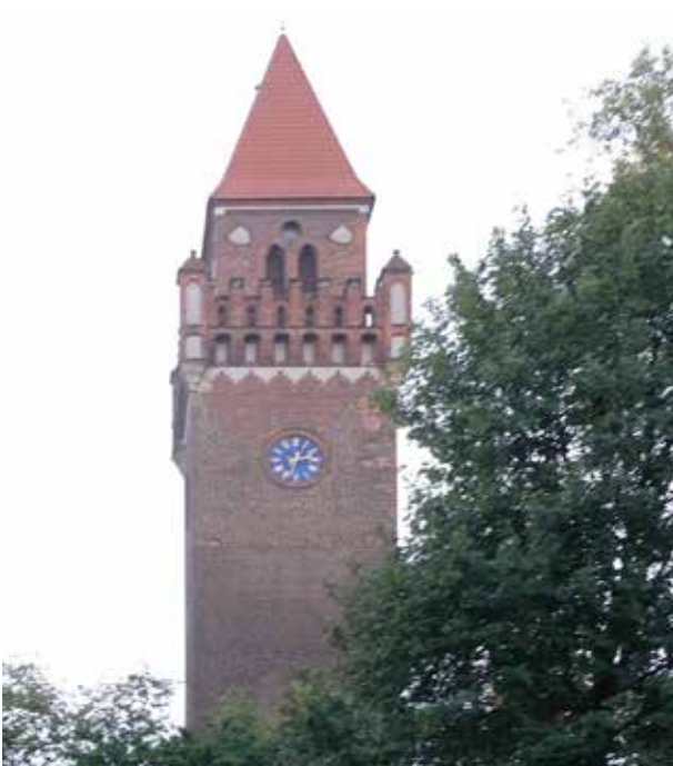
SCHLOSSTURM | Ältestes erhaltenes Gebäude in der Altstadt mit Sichtmauerwerk
