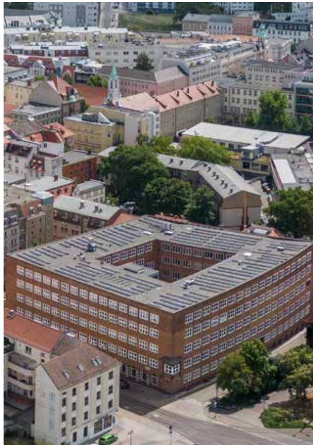
RATHAUS | Photovoltaikanlage auf dem Dach ist vom Straßenraum aus nicht einsehbar
