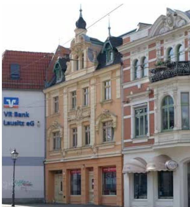
SANDOWER STRASSE Zwerchhaus mit durchgehender Traufe
