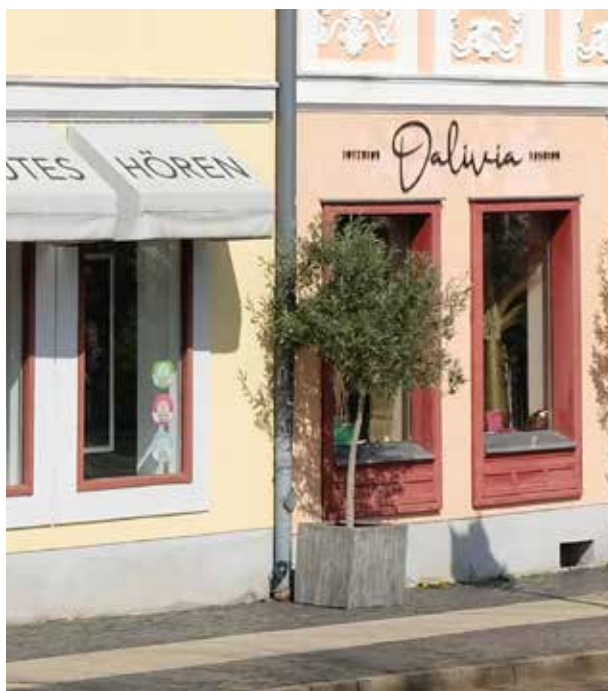
ALTMARKT Verputzter Sockelbereich
