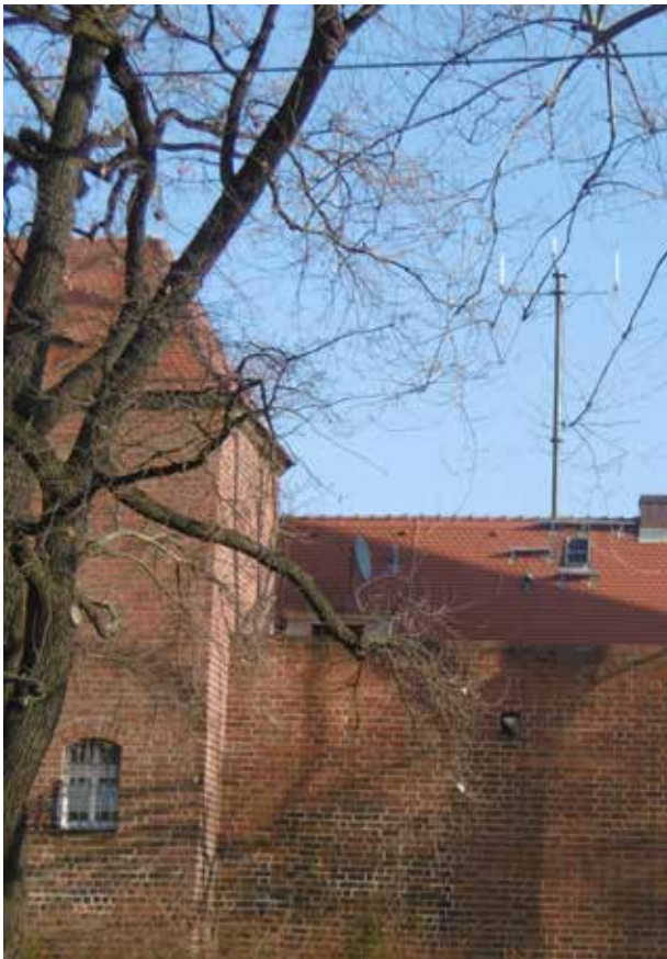
STADTMAUER | Blick auf Dach Mauerstraße 5 mit Antenne
