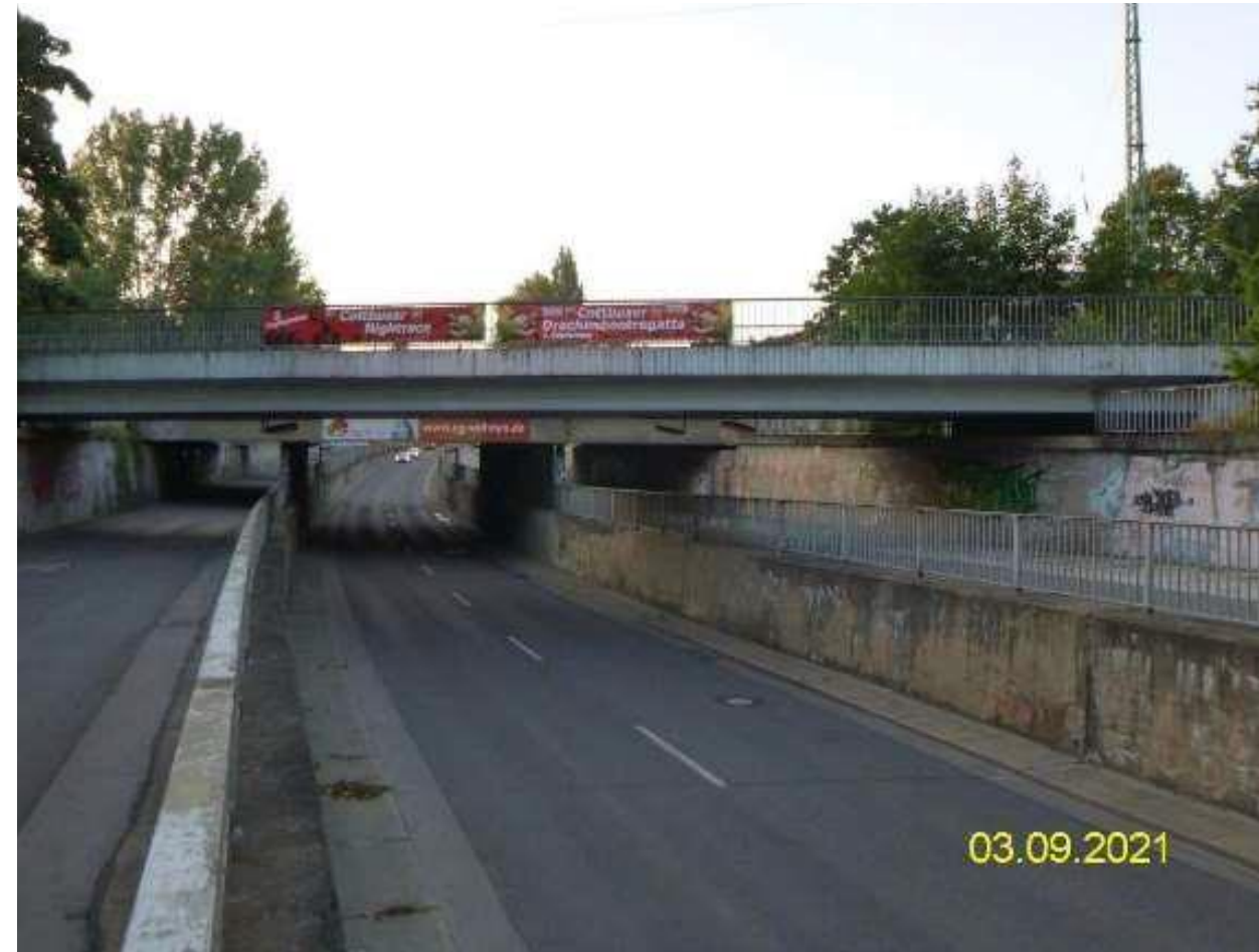
Foto Trogbauwerk, Willy-Brandt-Straße (FB Grün- und Verkehrsflächen)
